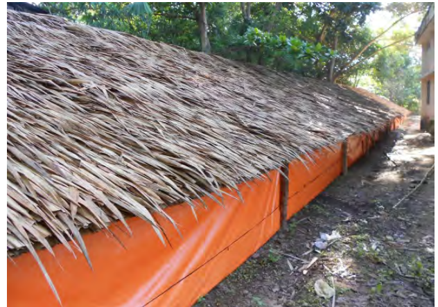
Hình 2.5.4. Mái che bằng lá
