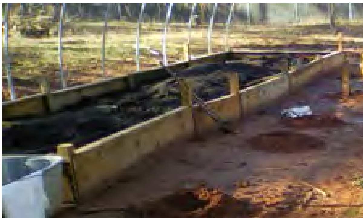
Hình 2.6.4. Luống tròn không mái che được vây bằng ván
