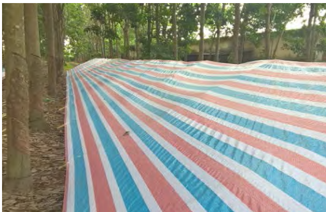
Hình 2.5.13. Lợp mái bạt cao su
