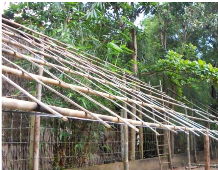
Hình 2.5.8. Khung mái che
