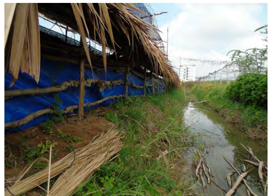
Hình 1.2.31. Hệ thống mương rãnh thoát nước
