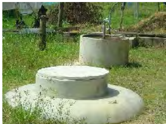
Hình 1.4.8. Hầm ủ biogas
