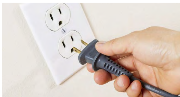
Hình 5.4.3. Kiểm tra nguồn điện
