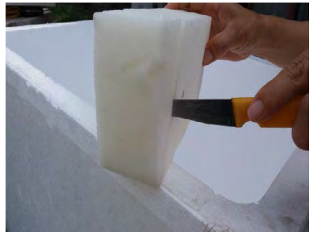
Hình 2.2.18. Dùng miếng mút nhét vào lỗ thoát nước
