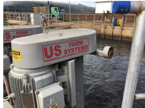
Hệ thống xử lý nước thải tại Trang trại bò sữa của Tập đoàn TH
