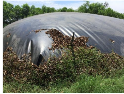
Bể KSH HDPE của Công ty TNHH MTV Tịnh Toàn, Hà Tĩnh
