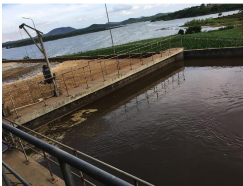
Nước thải tại Trang trại bò sữa của Tập đoàn TH sau khi xử lý được xả vào hồ Sông Sào (phía trên)
