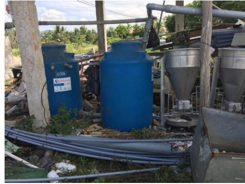
Thùng chứa phôi sắt để lọc KSH tại Công ty TNHH Thương mại và dịch vụ Thành Phú, Bình Định
