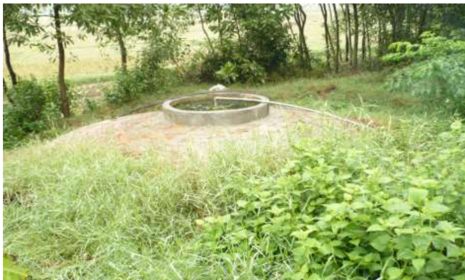
Hình 10. Công trình KSH nắp cố định có thể tích 300m 3
