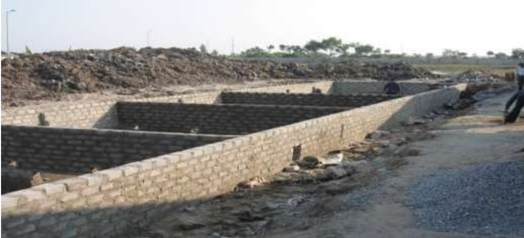
Hình 4. Công trình KSH xây dựng bằng gạch xi tại Công ty Tổng hợp Hà Nam
