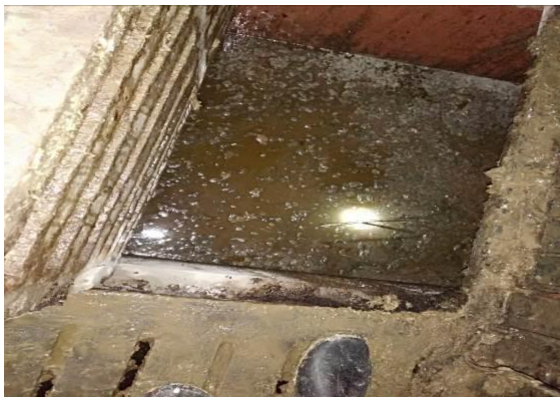
Hình 15. Hàm chứa chất thải sau 2 tháng nuôi thử nghiệm (đã hình thành lớp “váng” mỏng trên bề mặt có tác dụng ngăn mùi và khí độc hại bốc lên phía trên)
