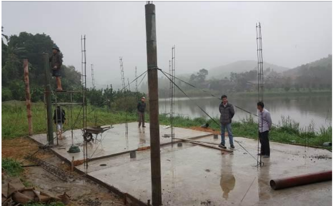
Hình 10: Đổ bê tông nền chuồng và cũng là đáy hầm chứa phân (trại ô.Từ Quang Vĩnh – Phú Thọ)
