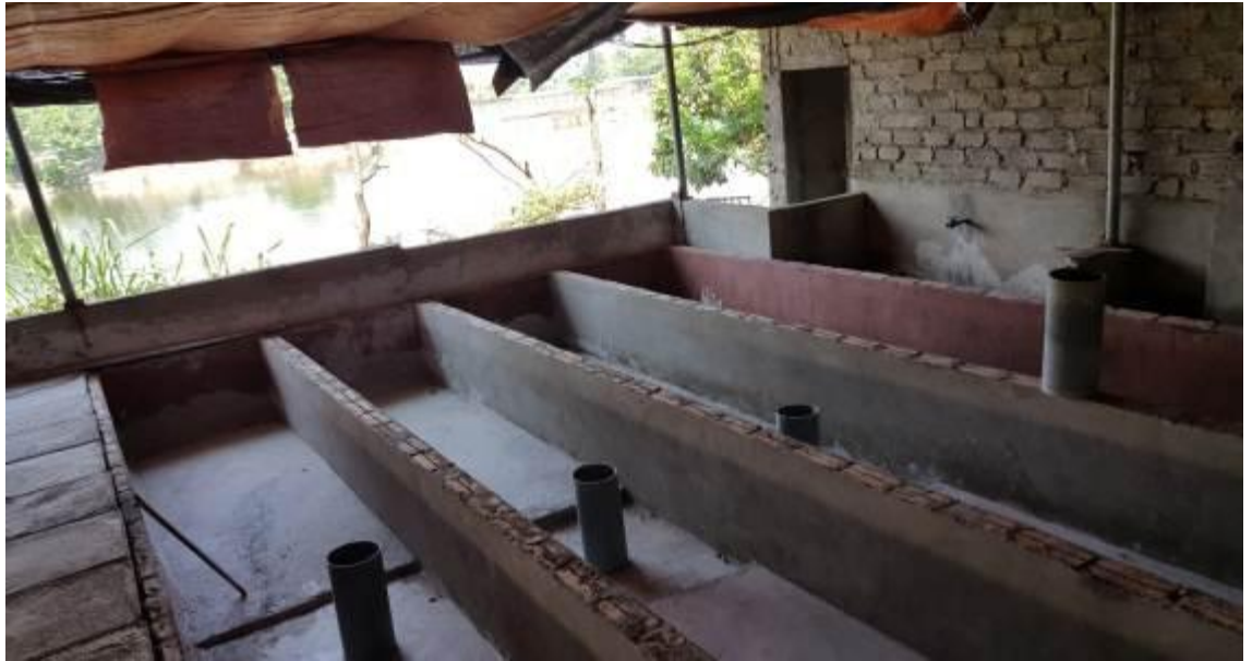
Hình 8. Cải tạo nền chuồng bê tông cũ thành bể chứa chất thải dưới sàn (trại ô.Tô Hiến Thành – Bắc Giang)
