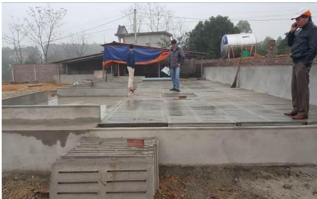
Hình 12: Lắp đặt tấm sàn bê tông tại trại ô.Vũ Đình Tuấn (Phú Thọ)
