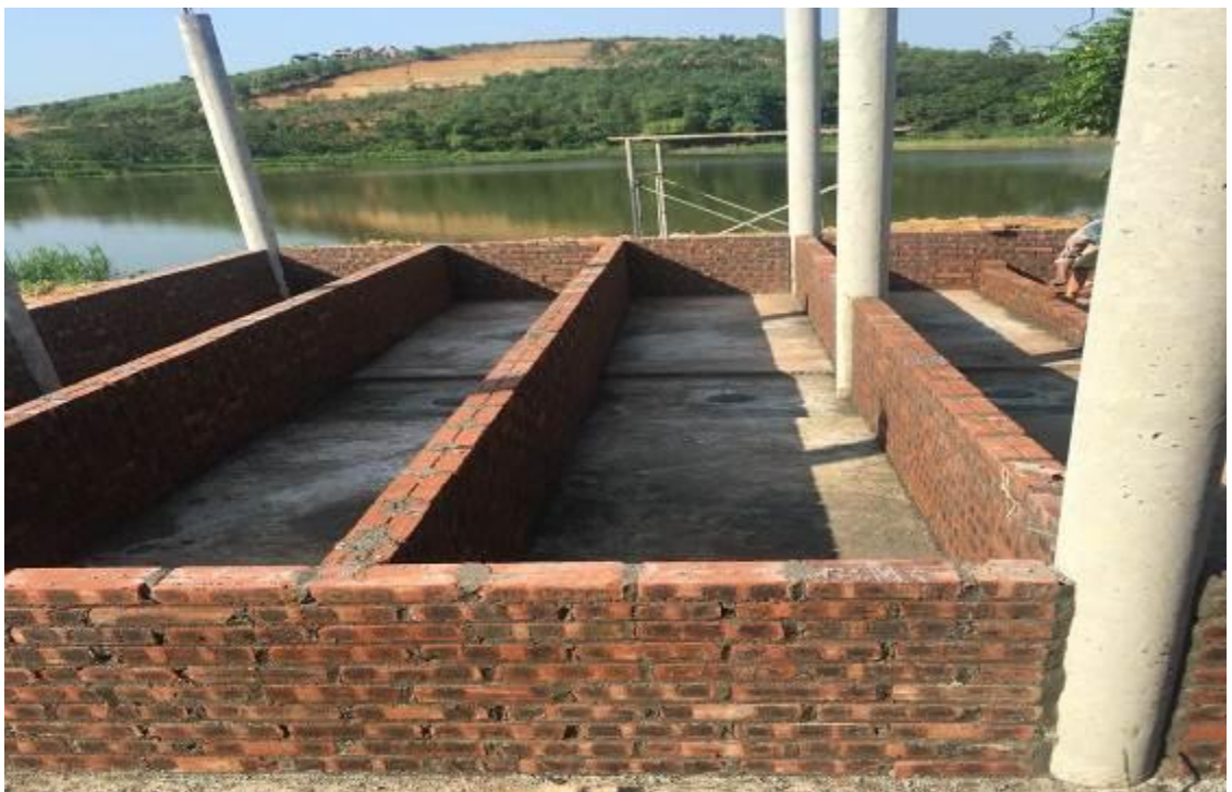
Hình 11: Hầm chứa phân dưới chuồng sà đang được xây dựng
