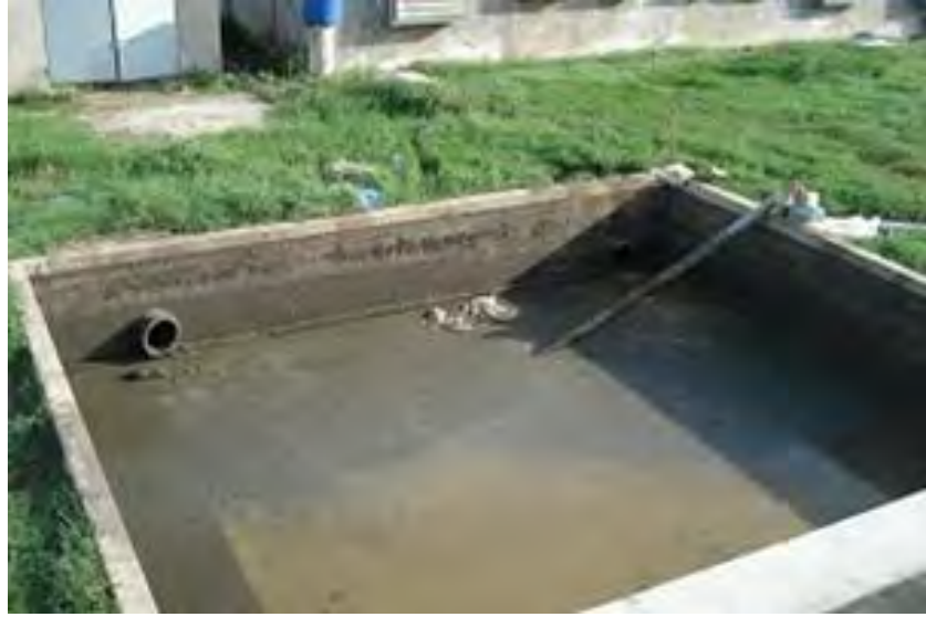
Hình 2.1.7. Nước thải hầm Biogas
